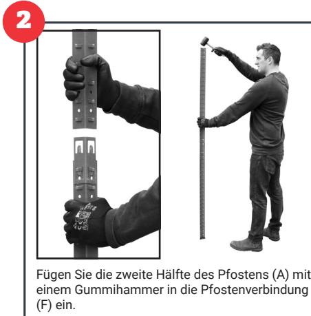
Fügen Sie die zweite Hälfte des Pfostens (A) mit einem Gummihammer in die Pfostenverbindung (F) ein.
