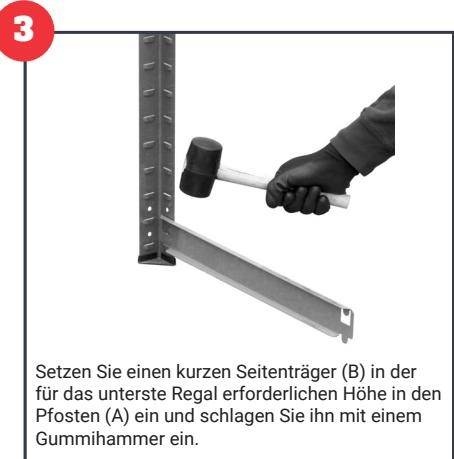
Setzen Sie einen kurzen Seitenträger (B) in der für das unterste Regal erforderlichen Höhe in den Pfosten (A) ein und schlagen Sie ihn mit einem Gummihammer ein.
